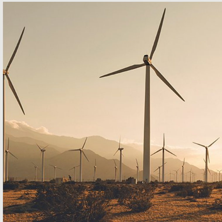
Ветроэлектростанция ENI в Казахстане; Источник: ENI
